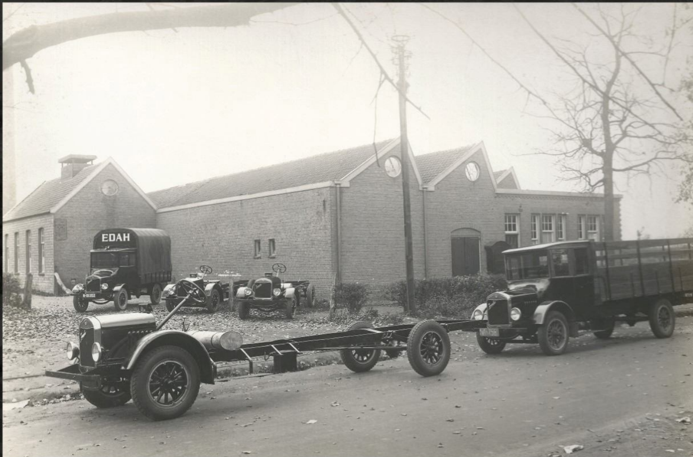
De toenmalige fabriek op de locatie aan de Mierloseweg, met vrachtwagens in aanbouw en reeds opgeleverde vrachtwagens van het merk Jumbo. De achterste wagen werd in opdracht van de Helmondse kruidenier EDAH gemaakt.
